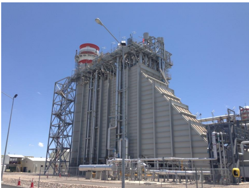
Typical HRSG – Monitor casing for hot spots
